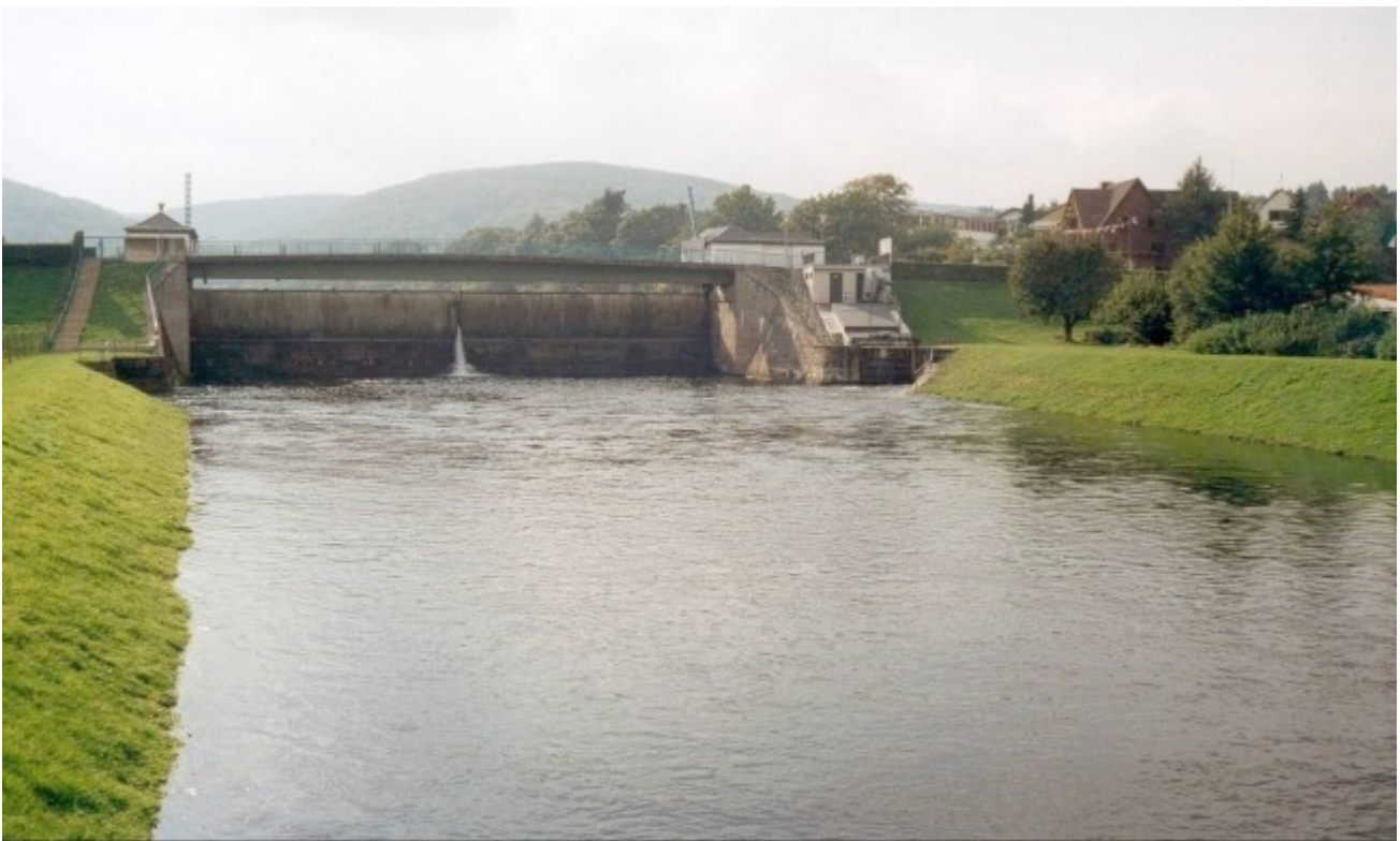
Rückansicht der Staumauer
